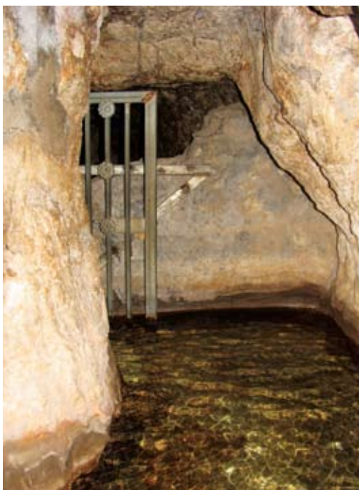
איור 18. מנהרה VI, הקטע הצפוני-מערבי והקיר החוסם את המעבר לכיוון פיר וורן, מבט לצפון-מערב
