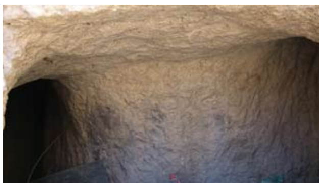
איור 22. פתח 106-5 - מקום המפגש של שתי קבוצות החוצבים. שימו לב לסימני החציבה מימין ומשמאל
